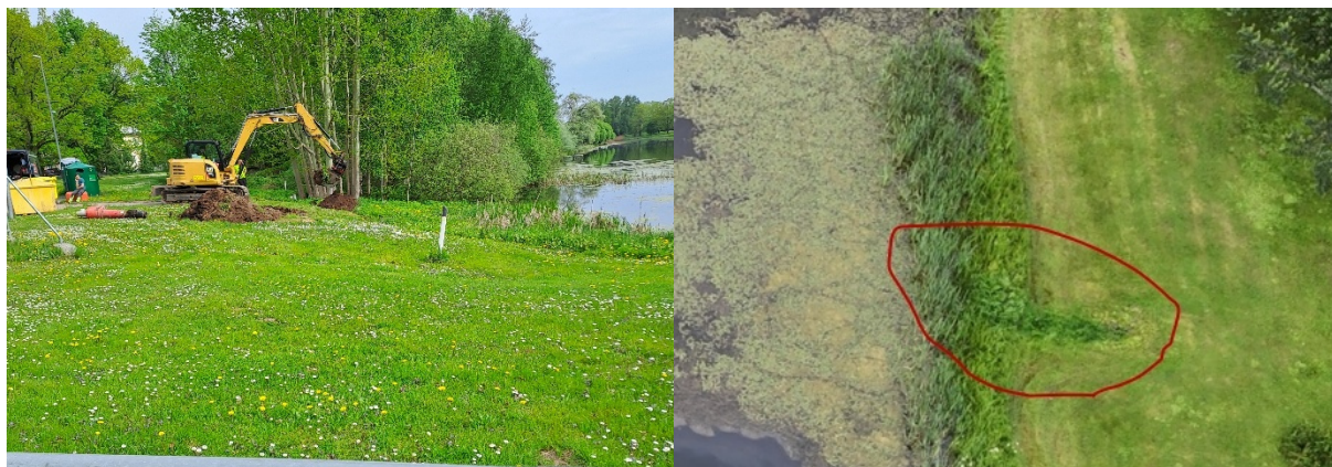
Foto 2 Kaevetööd ja hoonedrenaaži väljalask (foto Kadri Normak-Käosaar)
